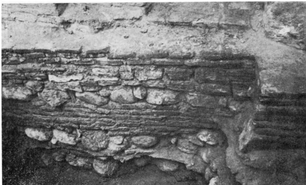
Рис. 6. Выравнивающий ряд плинфы над фундаментом юго-восточного столба
