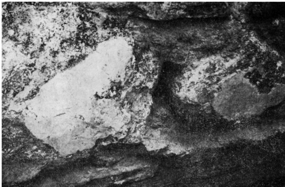
Рис. 5. Бутовый камень вторичного использования с цемяночной затиркой
