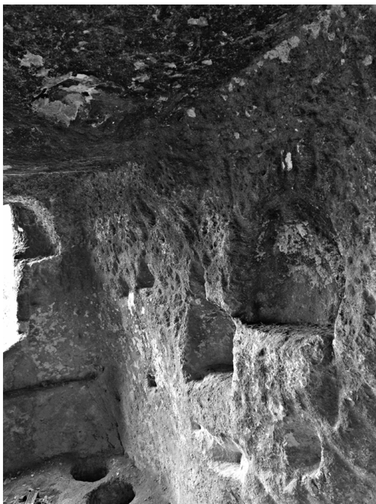
Фото 26. Ниши в южной стене помещения №2
