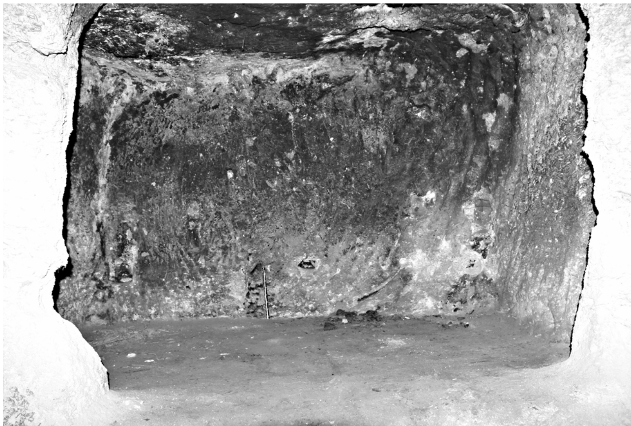
Фото 31. Западная стена помещения №3
