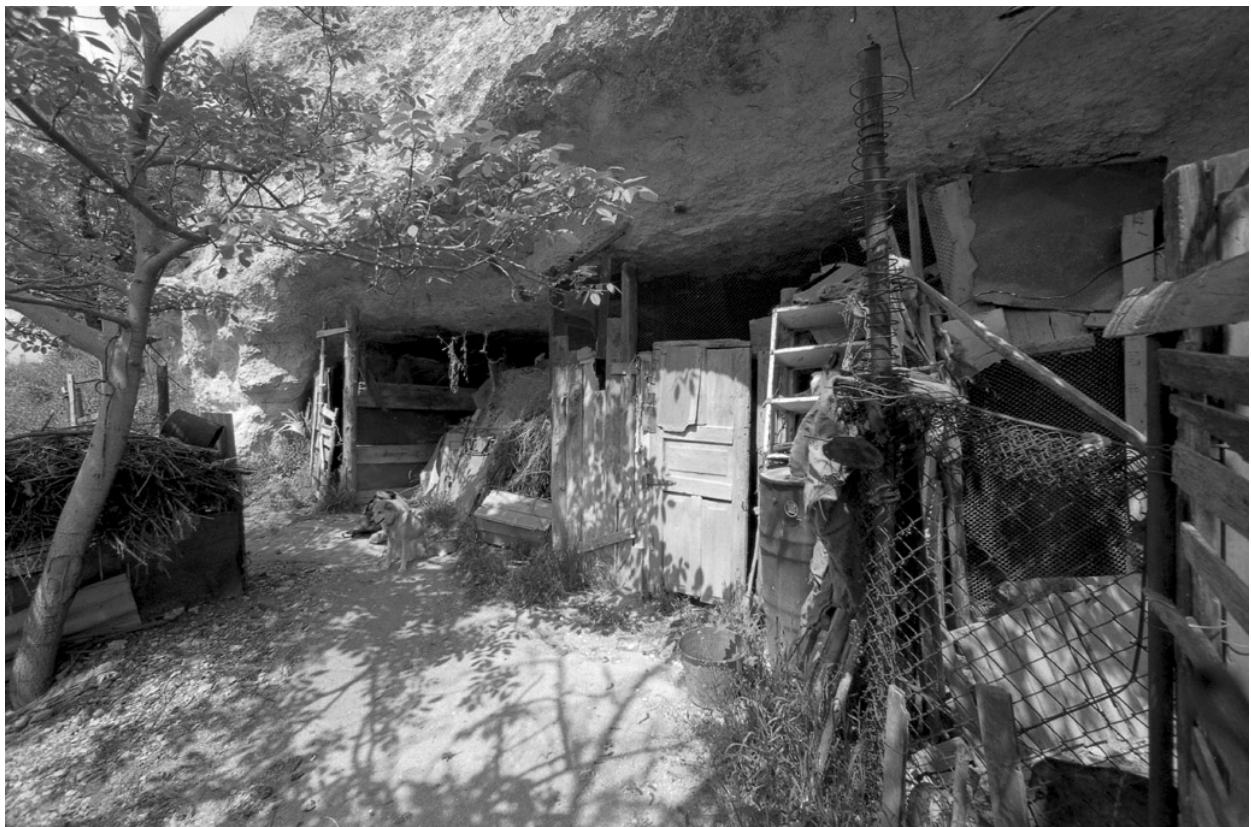
Фото 4. Помещения №1 и №2. Общий вид
