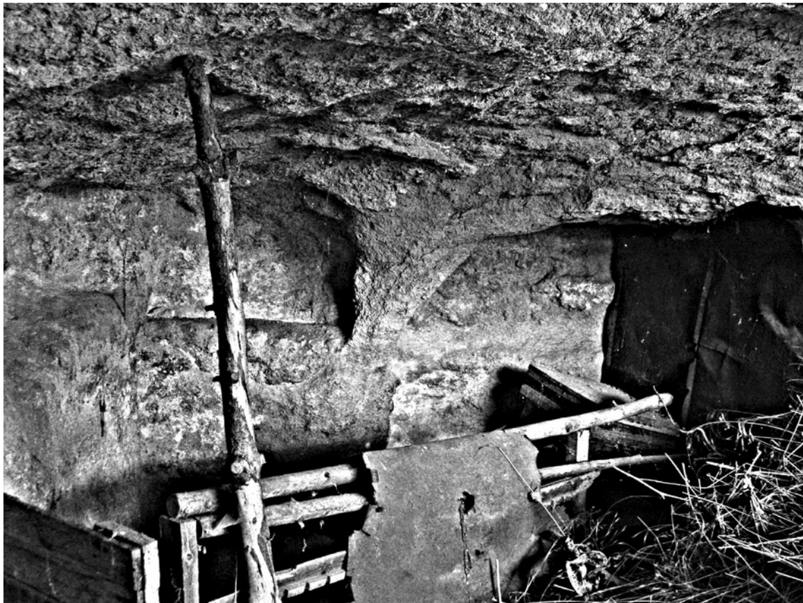
Фото 7. Ниши в северо-западной части помещения №1
