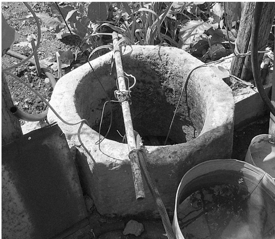
Фото 29. Колодец на участке дома 28а
