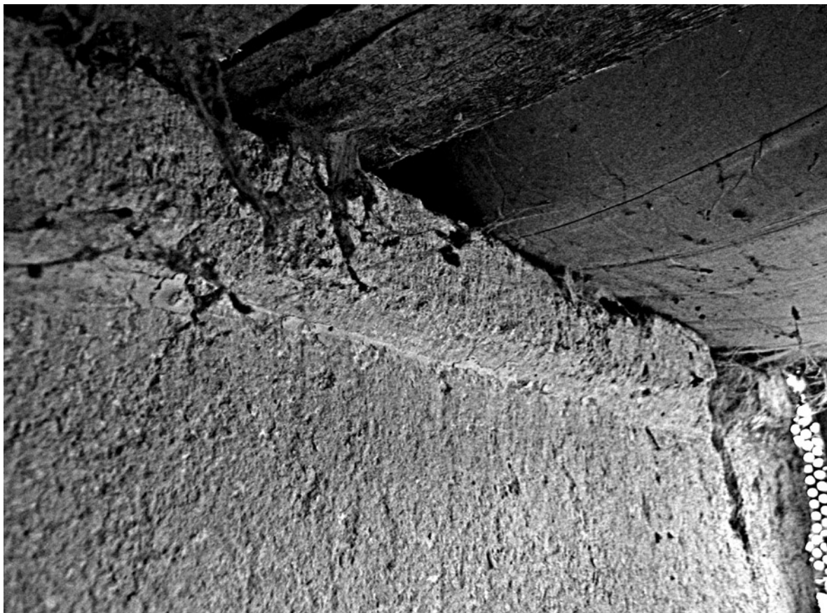
Фото 16. Карниз на восточной стене помещения №2
