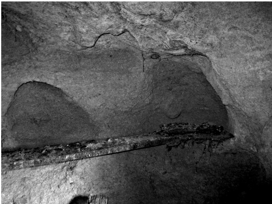
Фото 20. Ниши в северной части помещения №3
