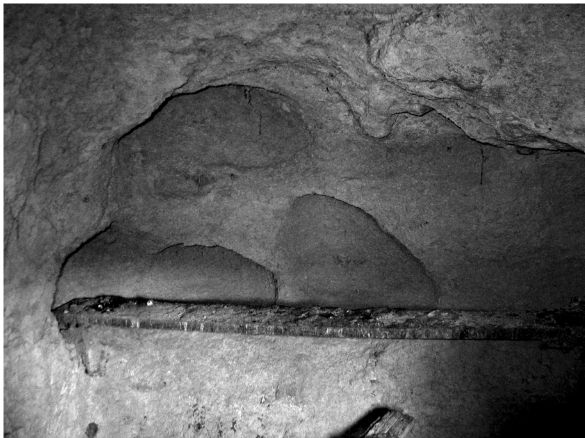
Фото 19. Ниши в северной части помещения №3
