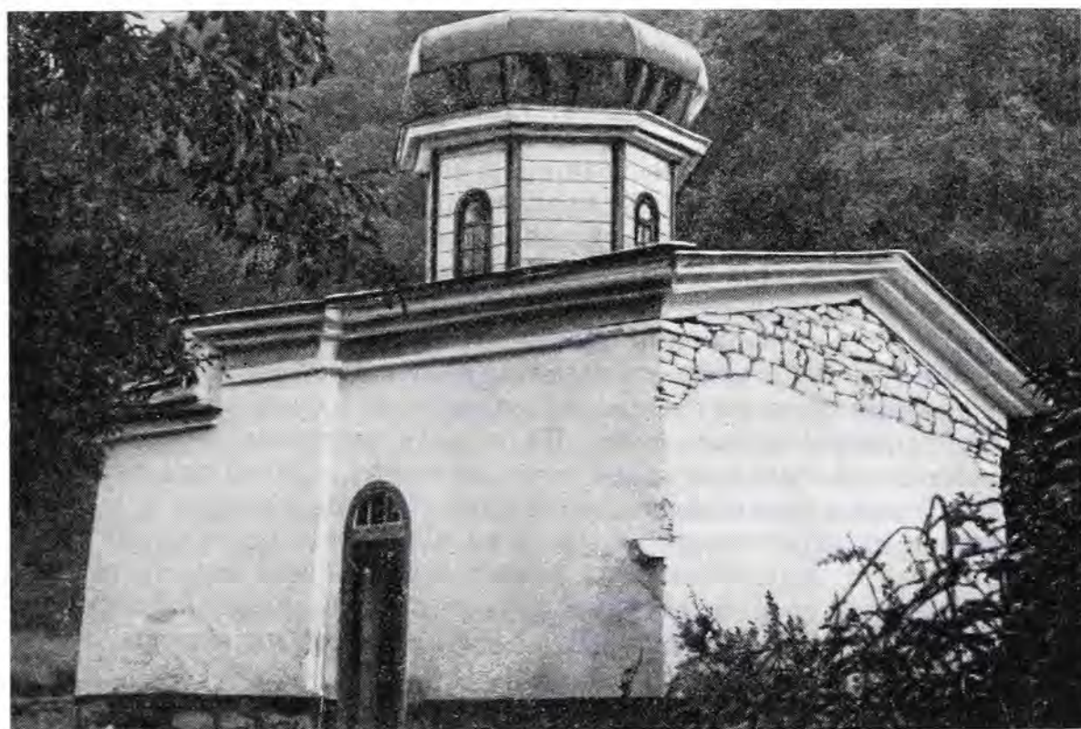
Рис. 2. Северный и западный фасады. Снимок 1968 г.
