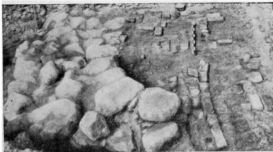
Рис. 3. Кирпичный пол в абсиде церкви. Слева видны валуны верхнего фундамента
