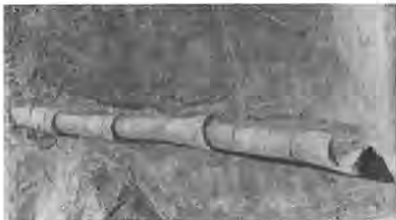
Рис. 4. Раскоп I. Участок канализационной линии
