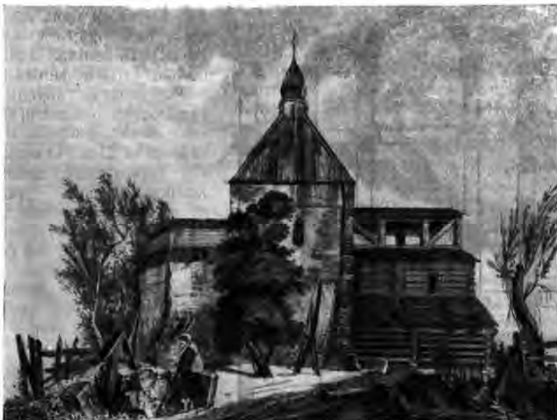
Рис. 4. Северная стена юго-западного помещения Десятинной церкви XI в., вошедшая в состав церкви XVII в.
