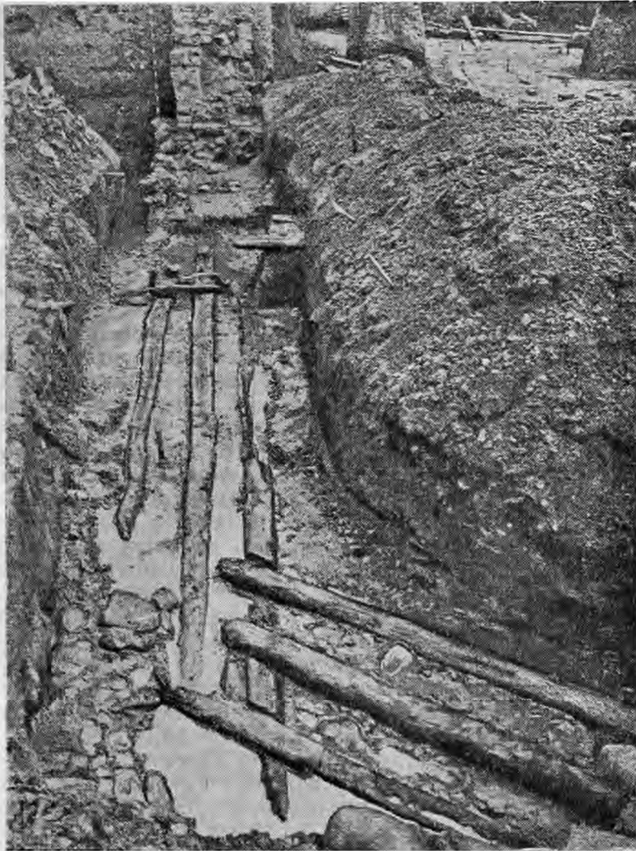
Рис. 31. Новгород. Борисоглебский собор. Дубовые лежни, заложенные под фундамент южной стены собора.
