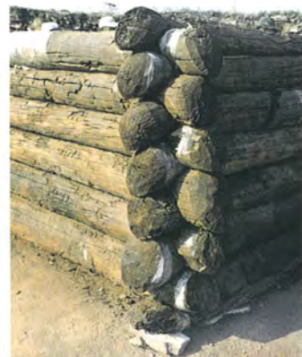
Abb. 253. Aržan 2, Grab 5. Rekonstruktion der inneren Kammer. 1 Nordostecke von außen; 2 von innen.
